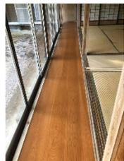
台所のシンクを新しくします。フローリングは夢工房の安藤が施工。ダイニングキッチンの壁は5月下旬に地元の方と珪藻土の塗り壁体験会をします。縁側の床は既存の床板の上に新しい床板を重ね張りしています。
