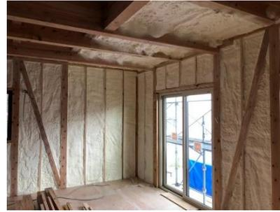
11月より着工していますN様邸。断熱材の吹き付けをしています。3月完成に向けて大工工事が進んでいます。
