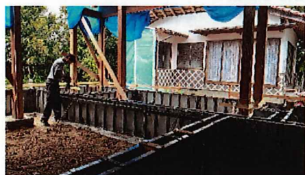
基礎を新設しています
