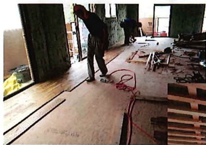
← フローリング施工中 素材はアカシアです
